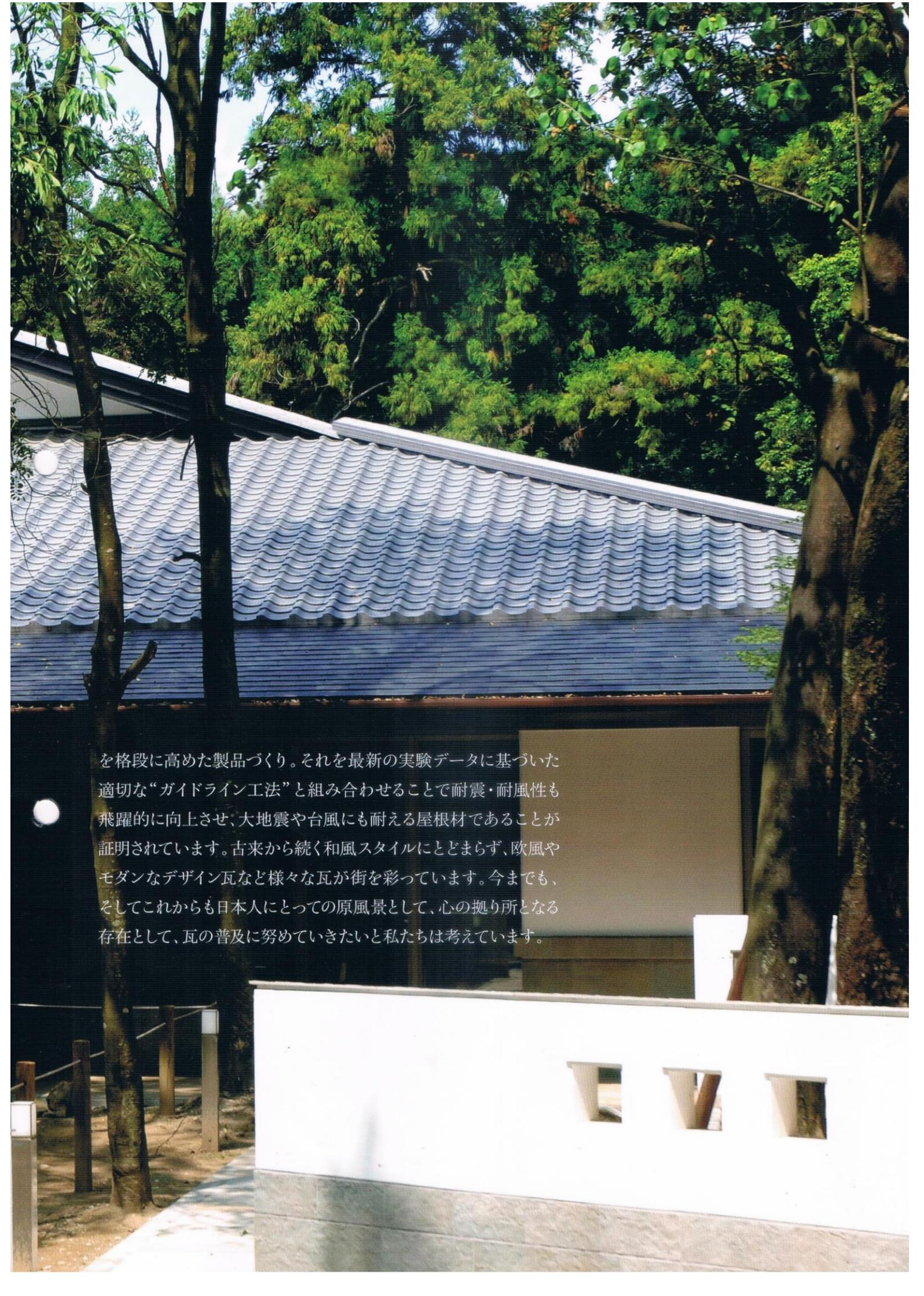
を格段に高めた製品づくり。それを最新の実験データに基づいた適切な“ガイドライン工法”と組み合わせることで耐震・耐風性も飛躍的に向上させ、大地震や台風にも耐える屋根材であることが証明されています。古来から続く和風スタイルにとどまらず、欧風やモダンなデザイン瓦など様々な瓦が街を彩っています。今までも、そしてこれからも日本人にとっての原風景として、心の拠り所となる存在として、瓦の普及に努めていきたいと私たちは考えています。
